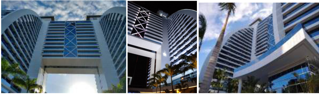
Figura 11- Visão Diurna e noturna da edificação
