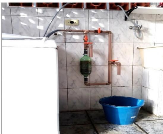
Figura 2 – Aparelho que filtra água da máquina de lavar que será reutilizada.
