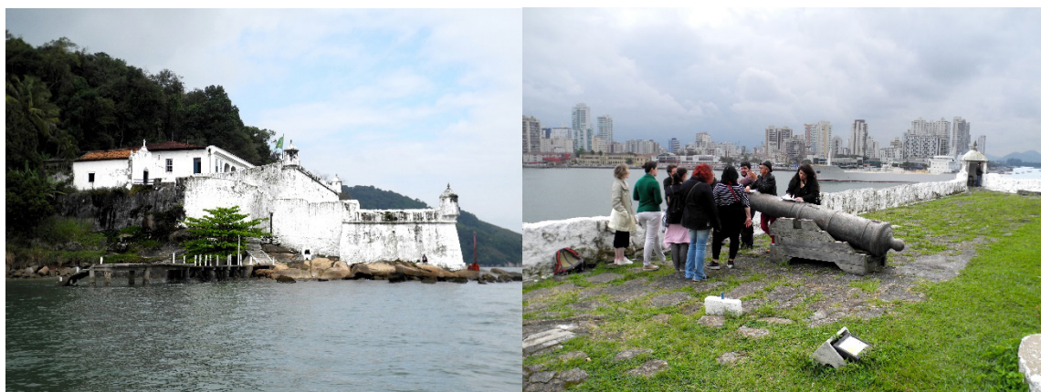
Figura 4 – Fortaleza de Santo Amaro da Barra Grande (c. 1582), vista geral do acesso pelo canal e aula na praça de armas.
