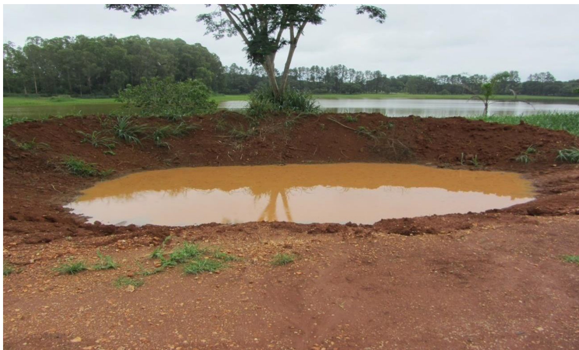
Figura 2. Barraginhas de Captação de água superficiais de chuvas CONVALES (2017a).
