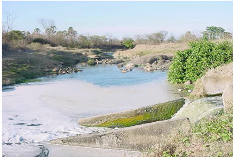
Figura 5. Lançamento de efluentes da ETE do Rio Maranguapinho
