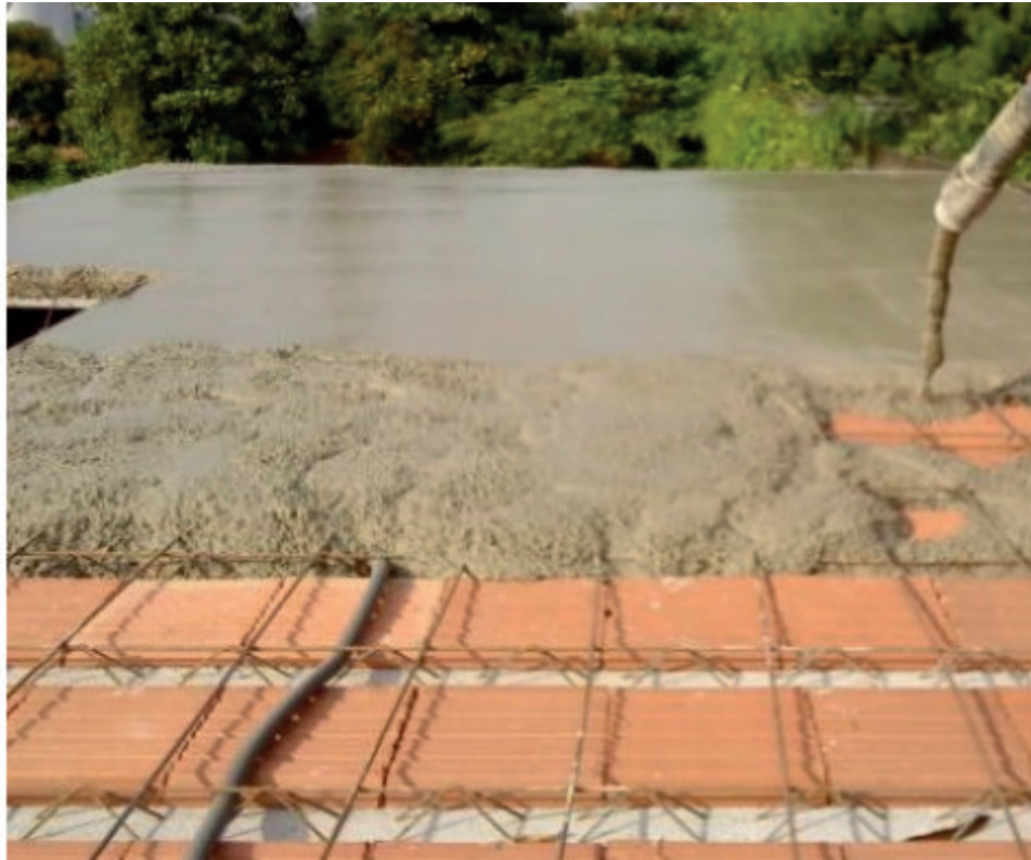
Figura 7 - Concretagem de laje com carga uniformemente distribuída
