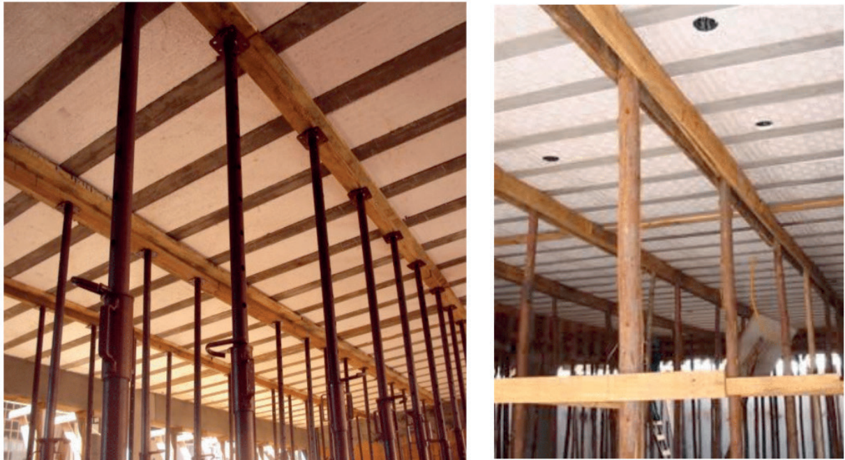
Figura 1 - Laje treliçada apoiada por escoras e longarinas
