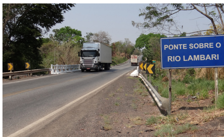
Figura 1 - Ponte sobre o Rio Lambari - Vista superior
