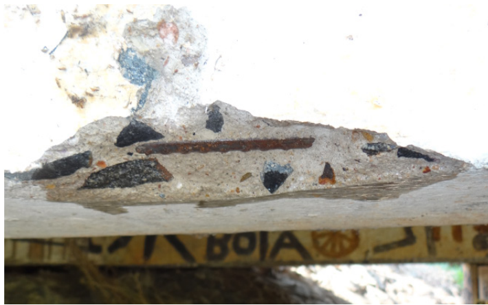
Figura 6 – Ensaio de carbonatação em longarina
