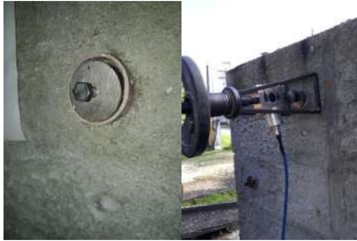
Figura 3 – Corpo de prova (esquerda) e ensaio de arrancamento (direita)
