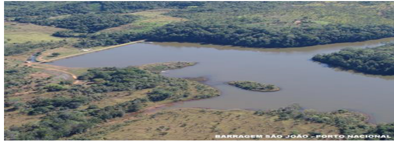
FIGURA 13 - Barragem no Córrego São João
