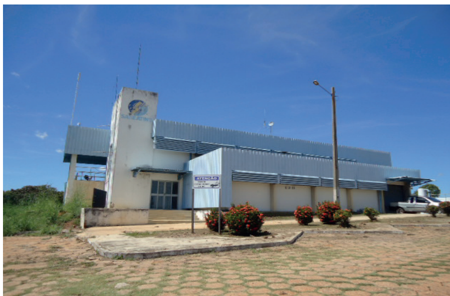
FIGURA 15 – Estação de Tratamento de Água de Porto Nacional – ETA 02
