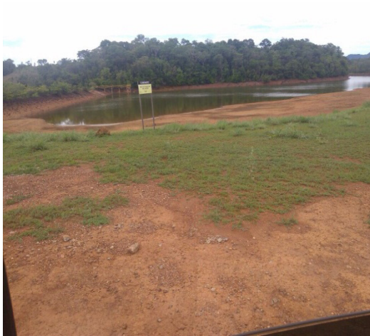
FIGURA 44 - Represa de Abastecimento Autora: Bernardeli, M. (07/12/2016)
