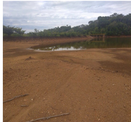
FIGURA 45 - Represa de Abastecimento Autora: Bernardeli, M. (07/12/2016)
