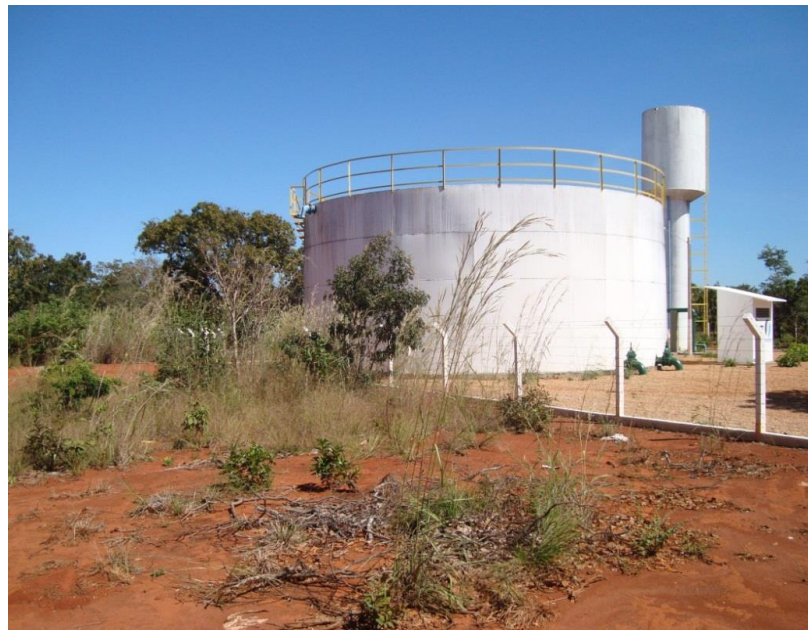
FIGURA 21 – Reservatório RAP e REL Ipês
