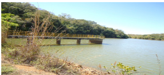
FIGURA 14 - Ponto de captação superficial na represa - Fazenda Jaiara
