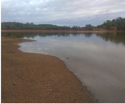
FIGURA 42 - Represa de Abastecimento Autora: Bernardeli, M. (07/12/2016)
