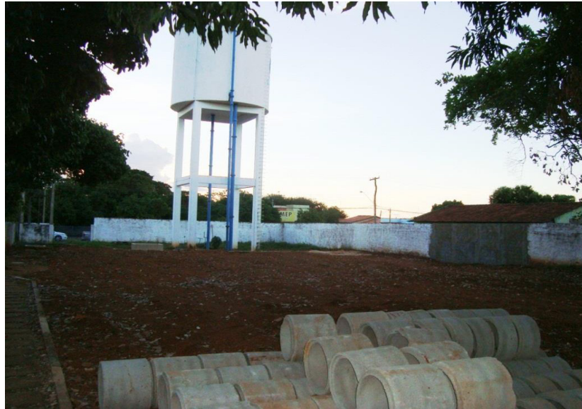
FIGURA 20 – Reservatório REL localizado no escritório da cia de abastecimento
