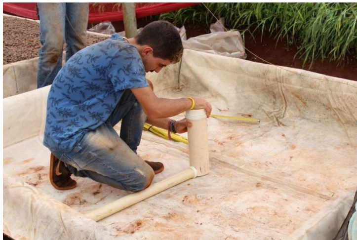
Figura 7. Detalhe do sifão do tipo “sino”. Fonte: Arquivo pessoal
