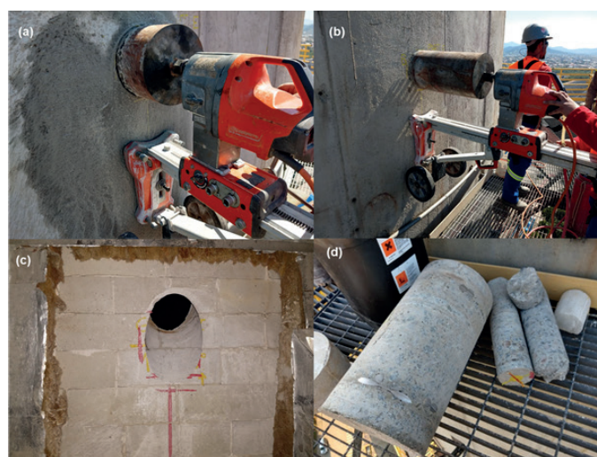
Figura 5. (a). Parede externa durante a furação. (b). Parede externa finalizando o primeiro furo. (c). Vista da parede interna depois de furada em diagonal para instalação do medidor de vazão. (d). Resíduos de concreto da furação.
