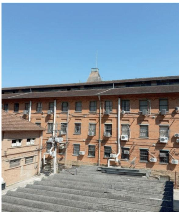
Foto 7 – Instalação de ar condicionado e dutos de escapamentos de gases laboratórios das unidades de ensino.
