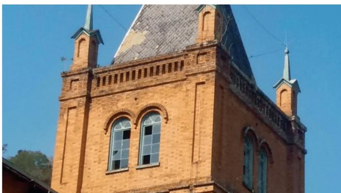
Foto 6 – Torre com vidros quebrados e telhado danificados
