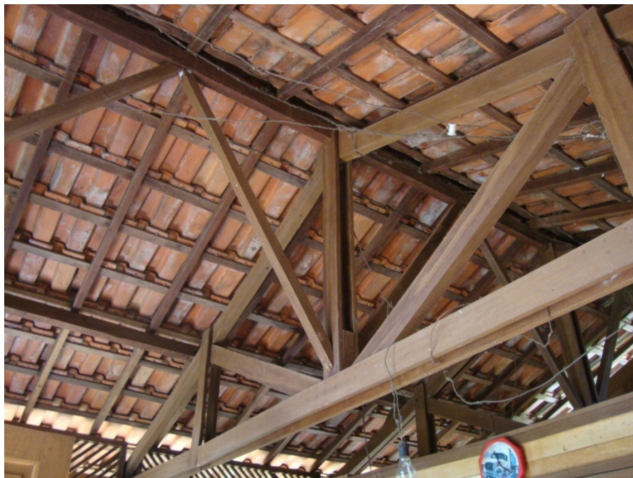
Figura 9 - Estrutura do telhado em perfeito estado
