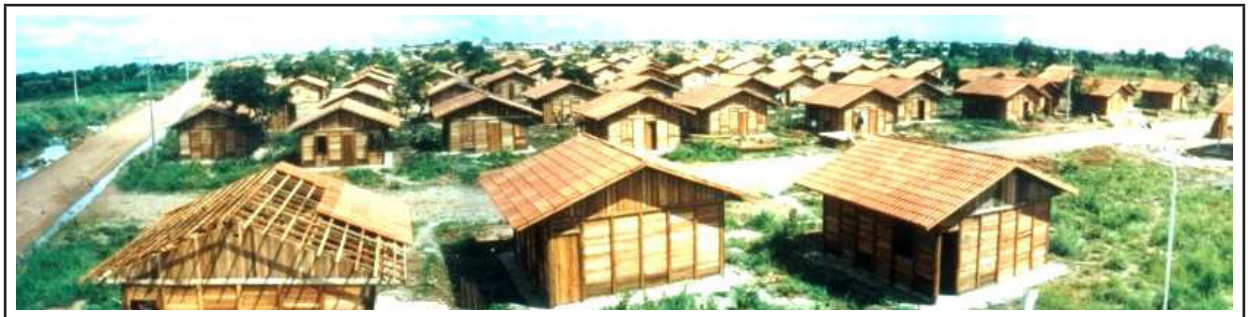
Figura 1 - Vista geral da implantação das unidades em canteiro de obra
