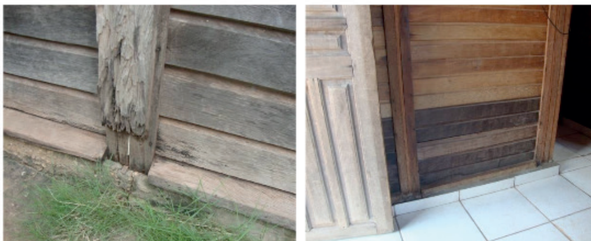
Figura 5 - Pannel de vedação: a) apodrecimento da peça mata-junta; b) Peças de madeira de maior dureza na base dos painéis
