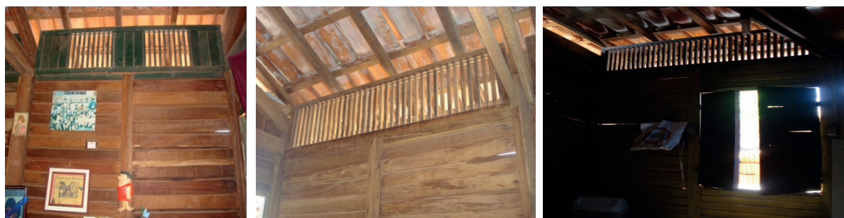
Figura 4 - Painéis de ventilação em bom estado.
