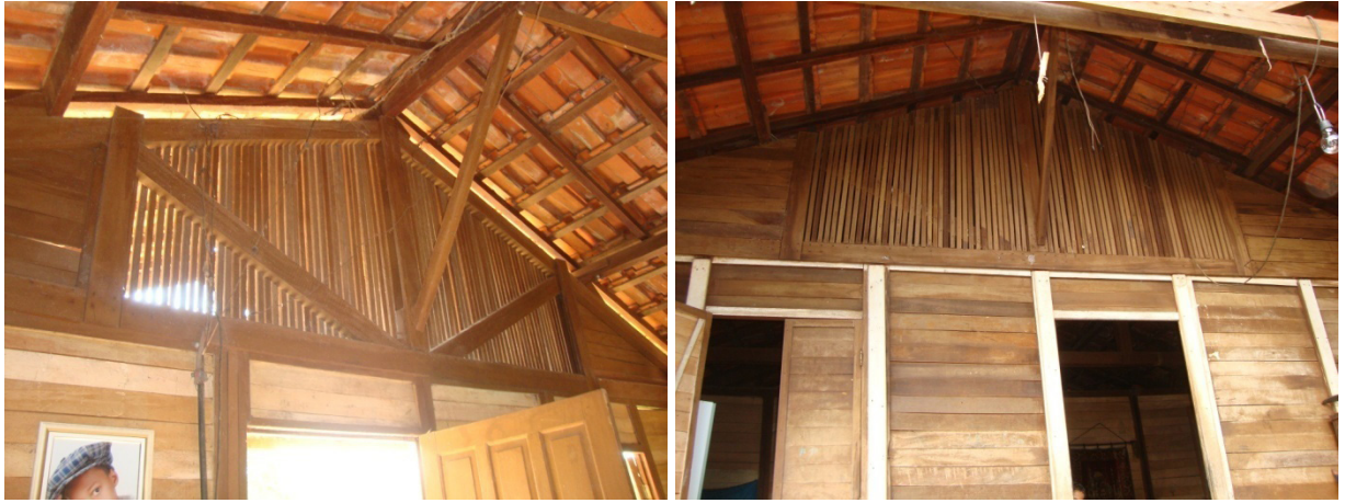
Figura 10 - Vista interna e externa do oitão frontal
