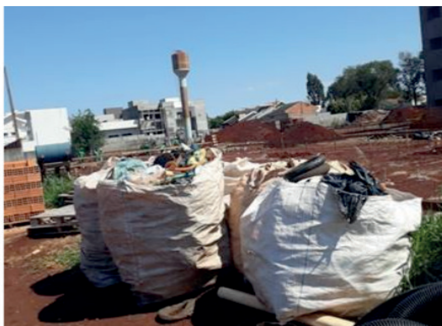
Figura 3. Acondicionamento de RCCs classe B
