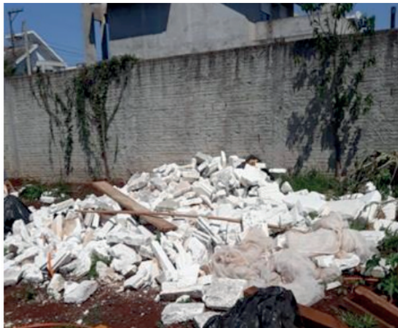
Figura 5. Resíduo de gesso gerado na obra
