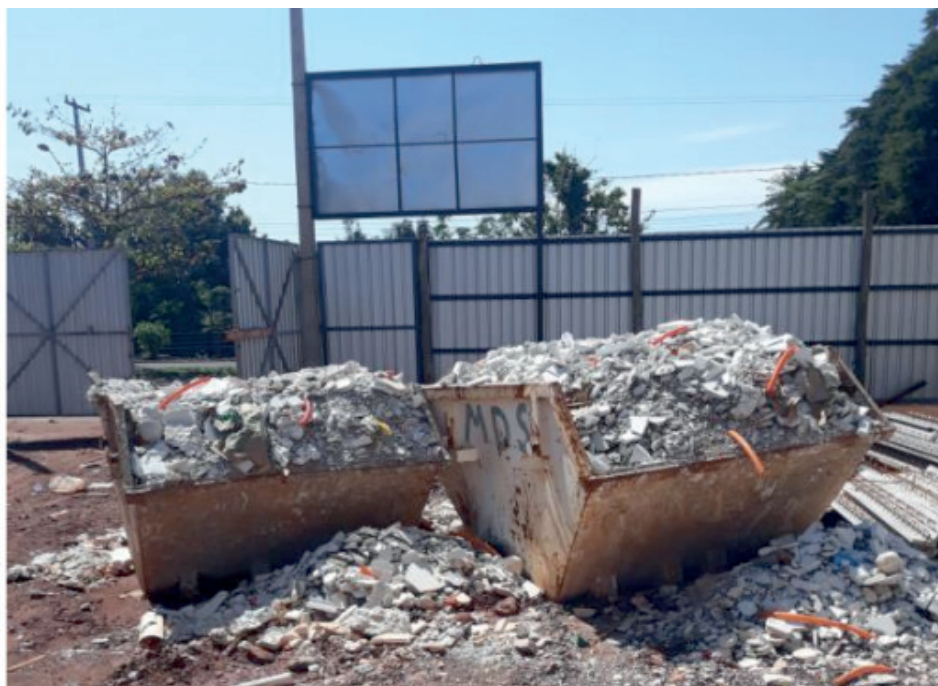
Figura 6. Disposição de resíduos em caçambas metálicas
