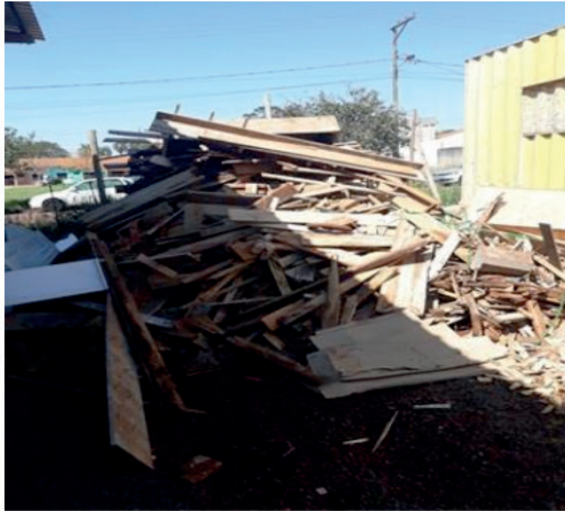
Figura 4. Resíduo de madeira gerado no canteiro
