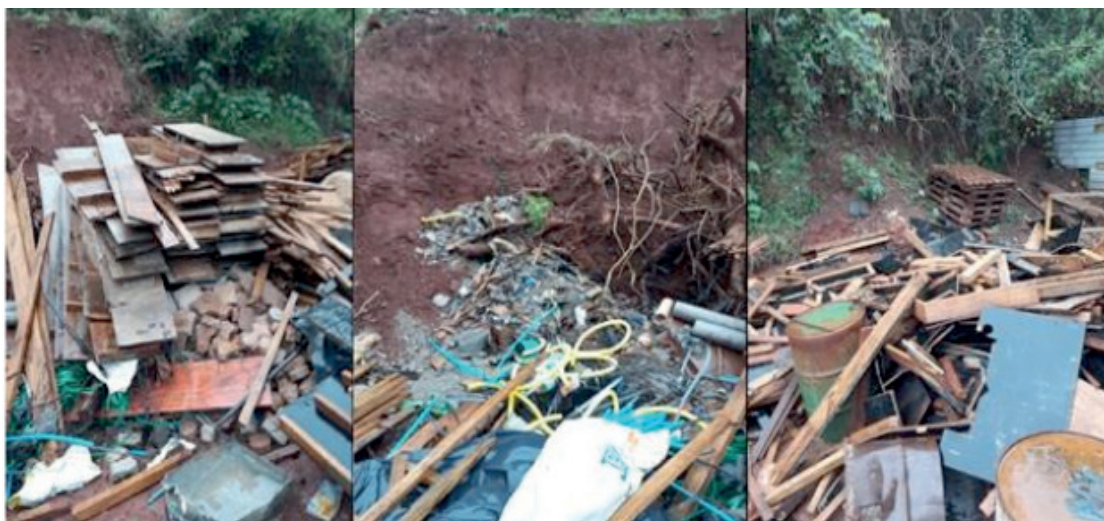
Figura 2. Disposição dos RCCs no canteiro de obra da empresa A
