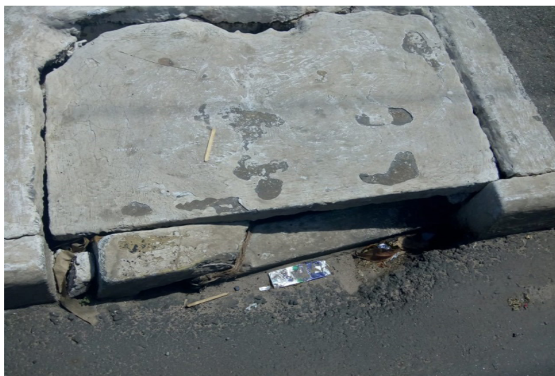
Figura 06 – Fotografia do sistema de captação das águas pluviais – Avenida ACM Fonte: Trabalho de Campo da Pesquisa Sistema Clima Urbano na Cidade de Salvador, BA. 2018.
