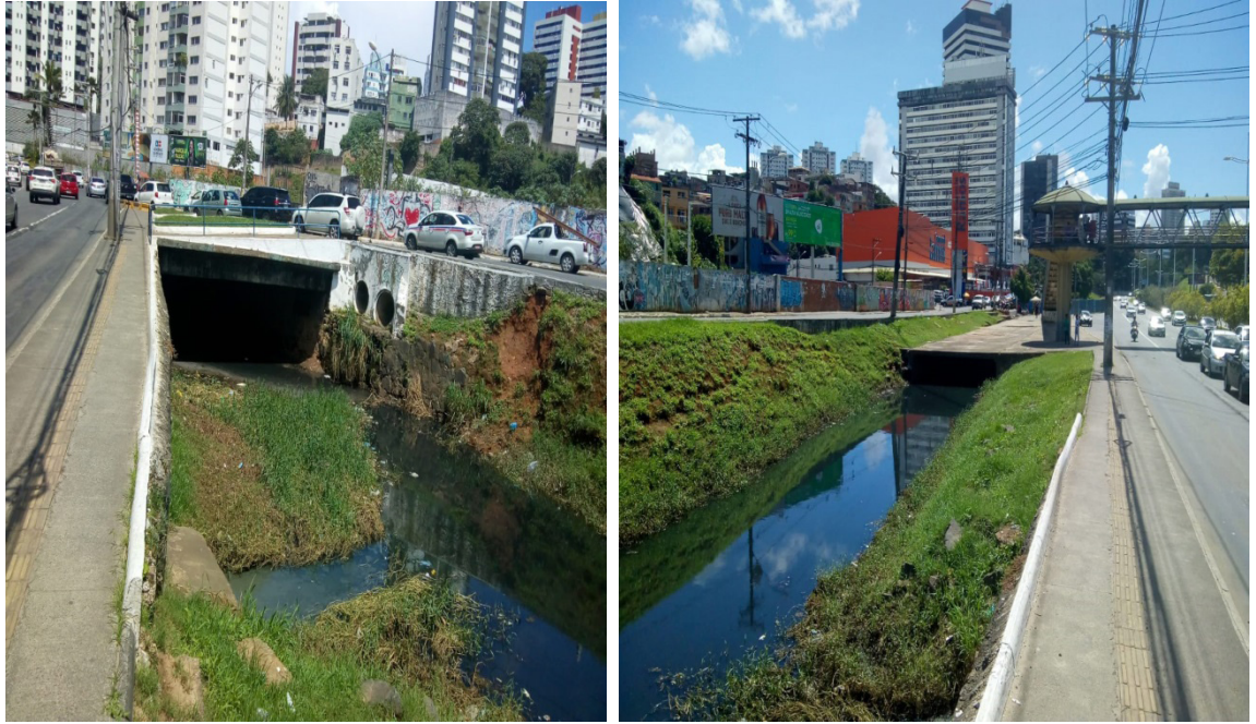
Figura 08 – Canais de macrodrenagem às margens da Avenida Antônio Carlos Magalhães
