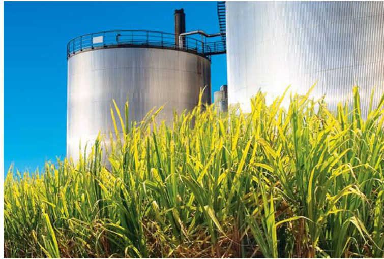
Foto 03- Usina para produção de etanol e energia elétrica em São Paulo
