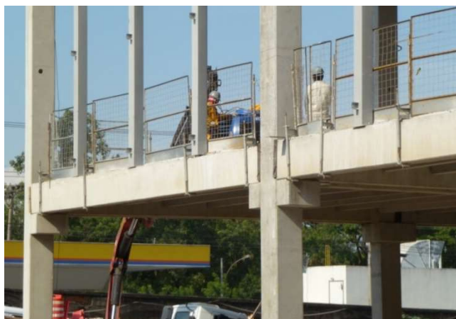
FIGURA 5 – Instalação inadequada de guarda-corpo
