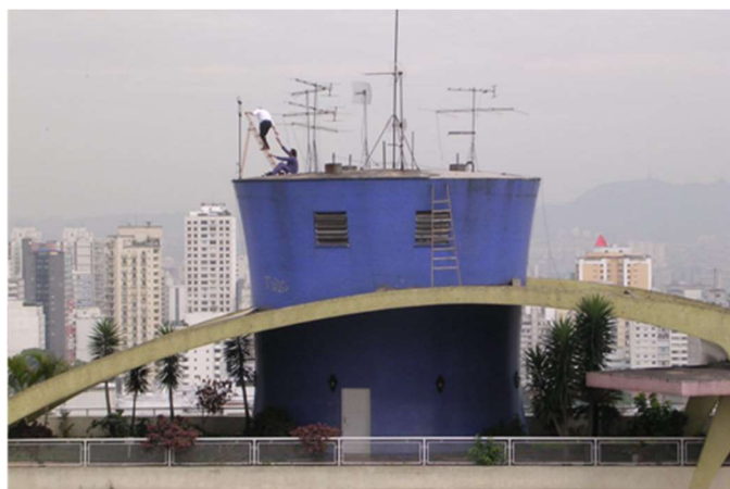
FIGURA 6 – Instalação de antenas.
