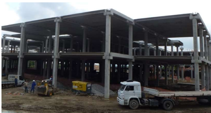
FIGURA 4 – Obra na fase de montagem da estrutura com pré-moldados
