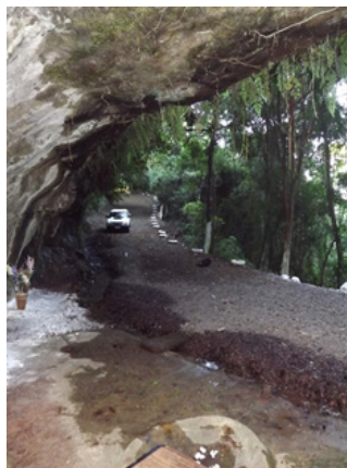
Figura 13 - Visão geral englobando acesso à rampa de acesso a toca e ao cimento existente no interior da gruta.
