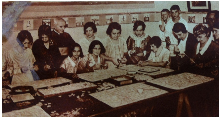
Figura 9: Montagem das placas de mosaico em pedra-sabão.
