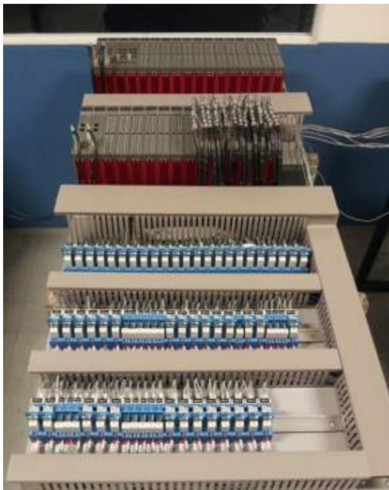
Figura 5: Placa de Montagem Painel da Unidade de Controle Digital (novo)
