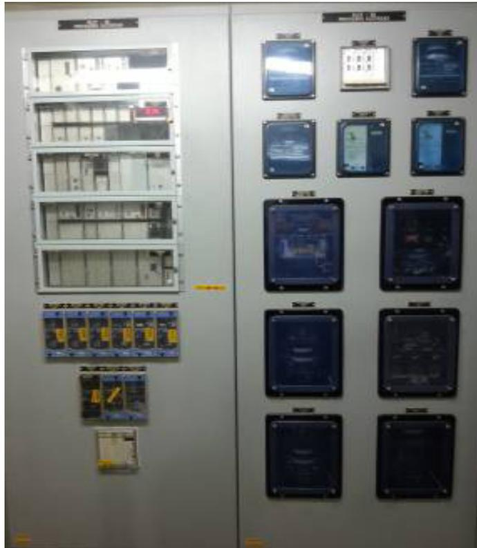
Figura 6: Painel dos Relés Proteção (antigo)
