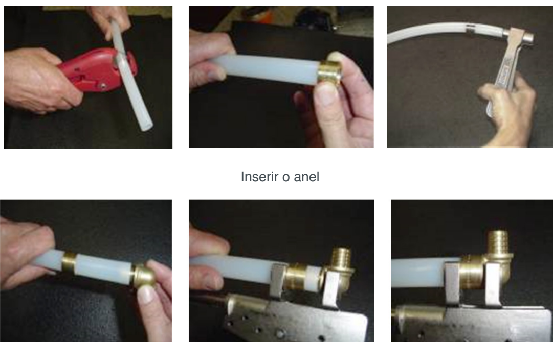
Figura 24 - Instalando PEX - EPEX Indústria e Comércio de Plástico
