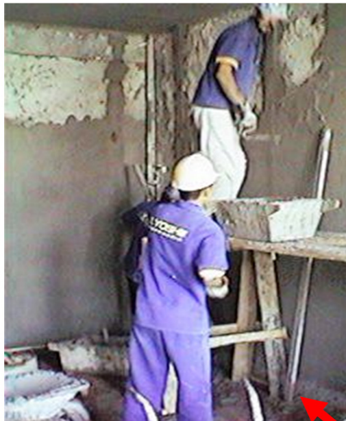
Figura 07: Parede de alvenaria tradicional – desperdício Fonte: ZULIAN (2002)
