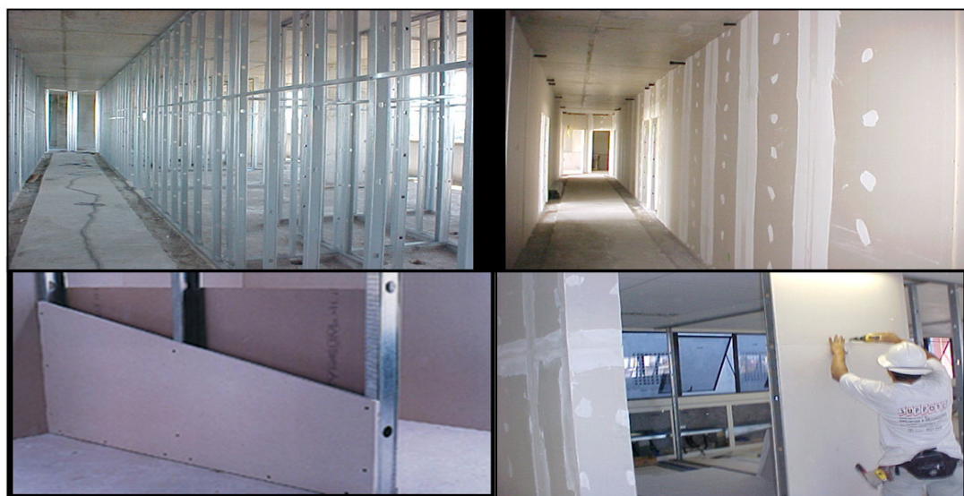
Figura 13: Parede de gesso acartonado (ESGA) - Fonte própria
