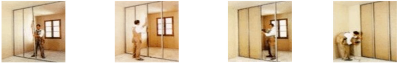
Figura 17 - Etapas de execução das paredes de gesso acartonado
