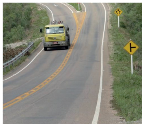
B - Defesa Metálica
