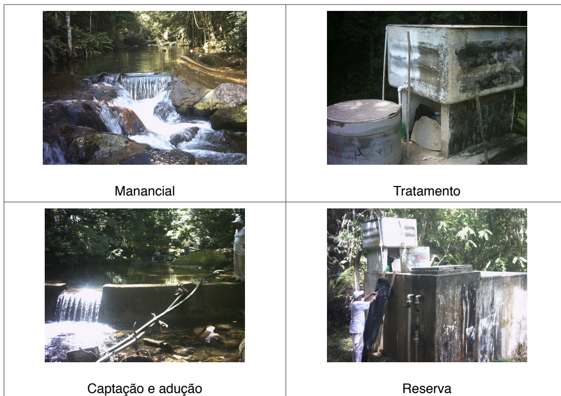
FIGURA 6 – SISTEMA DE CAPATAÇÃO DE ÁGUA DA COLÔNIA MARIA LUIZA
