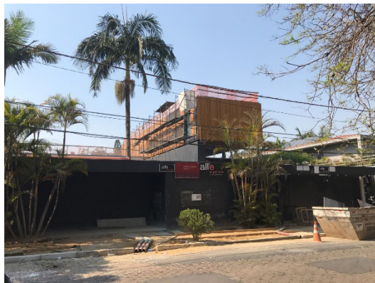
Figura 13: Construção recente (estrutura metálica) Rua Doutor Ibsen da Costa Manso
