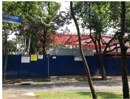
Figura 14: Construção recente (estrutura metálica). Rua Bucareste, 388.
