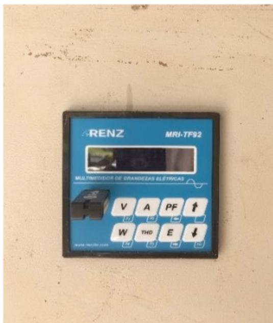
Figura 2. Multimetro de grandezas elétricas instalado no Bloco de Salas Especiais – Unidade Tapajós.
