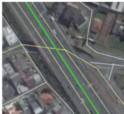
FIGURA 5a – Trincheira e rio canalizado.
