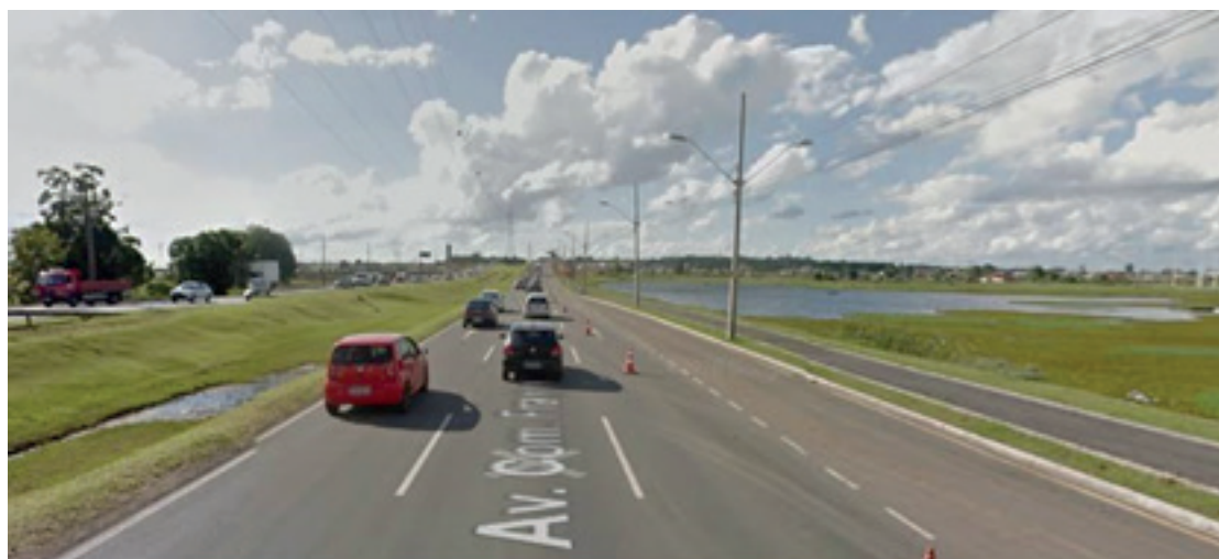
FIGURA 10 – Frentes de trabalho para implantação da LTS 230kV CTC-UBR.
