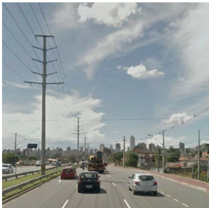
FIGURA 11 – Frentes de trabalho para implantação da LTS 230kV CTC-UBR.
