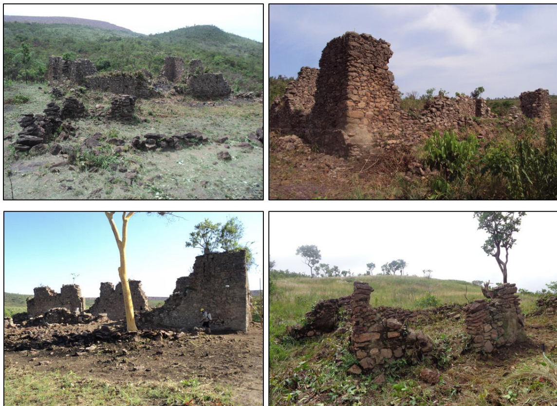
Figura 2. Exemplos de remanescentes das edificações que compõem a área nuclear do Arraial de São Francisco Xavier da Chapada (ZANETTINI ARQUEOLOGIA, 2011).
