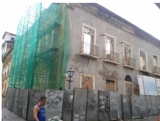
Figura 02: Obra de reforma e adaptação para habitação na Rua da Palma, Desterro
