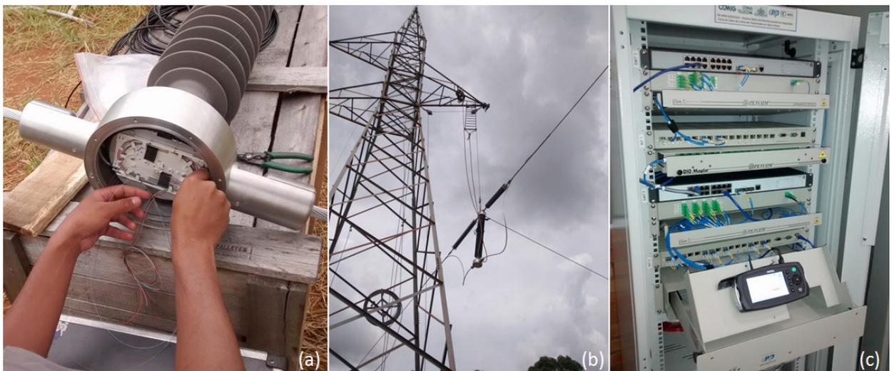
FIGURA 6 - Instalação na UniverCemig do sistema de monitoração e transmissão de dados: (a) realização das emendas na base do isolador, (b) instalação do cabo sensor e (b) rack do equipamento CWDM.
