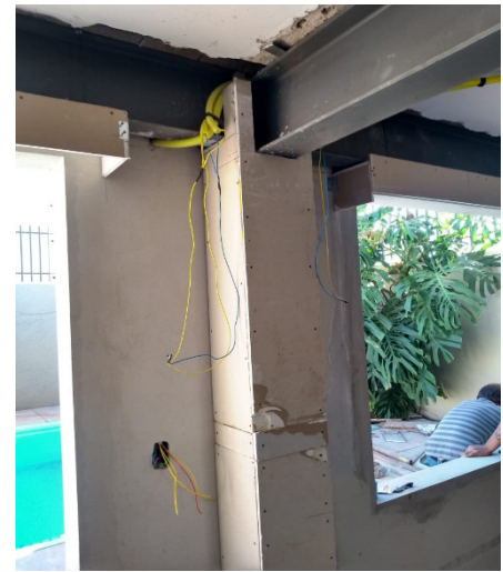
Figura 03: Execução do Pilar Fonte: Autoria Própria
