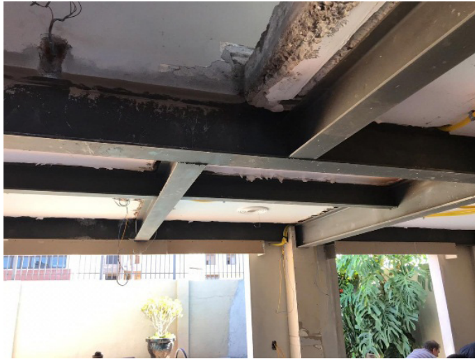
Figura 02: Execução das Vigas Fonte: Autoria Própria
