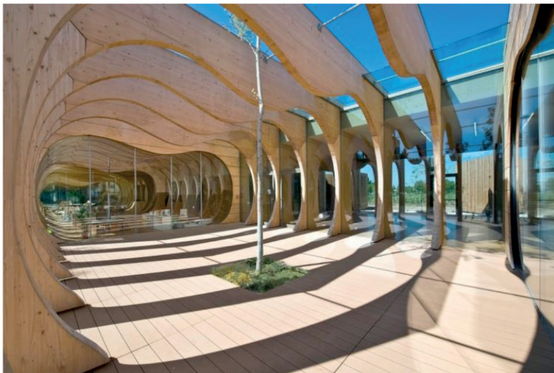
Figura 03- Creche que adere à caracterização de aquário, em Reggio Emília, projetada pelo escritório Mario Cucinella Architects.
