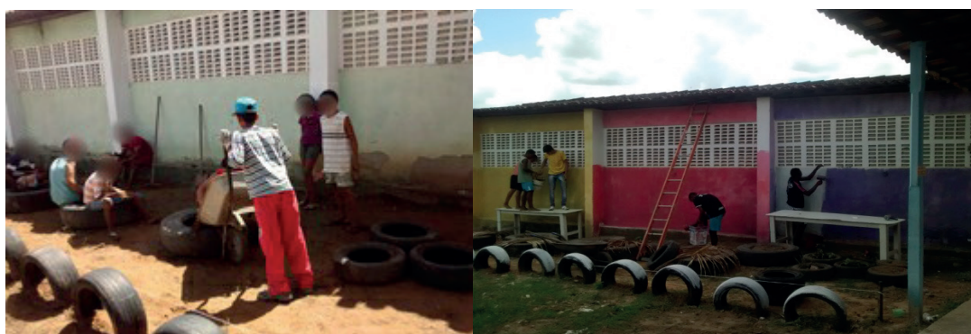
Figura 3: Montagem dos canteiros com pneus usados, medição da área e paisagismo. Fonte: Arquivo da autora (2016).
