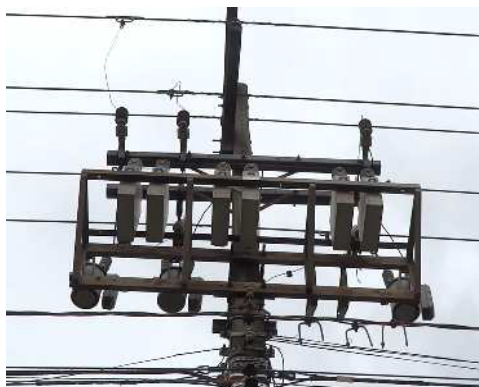
Figura 3 – Banco de capacitores montado em rede de distribuição. (Fonte: Copel Distribuição)
