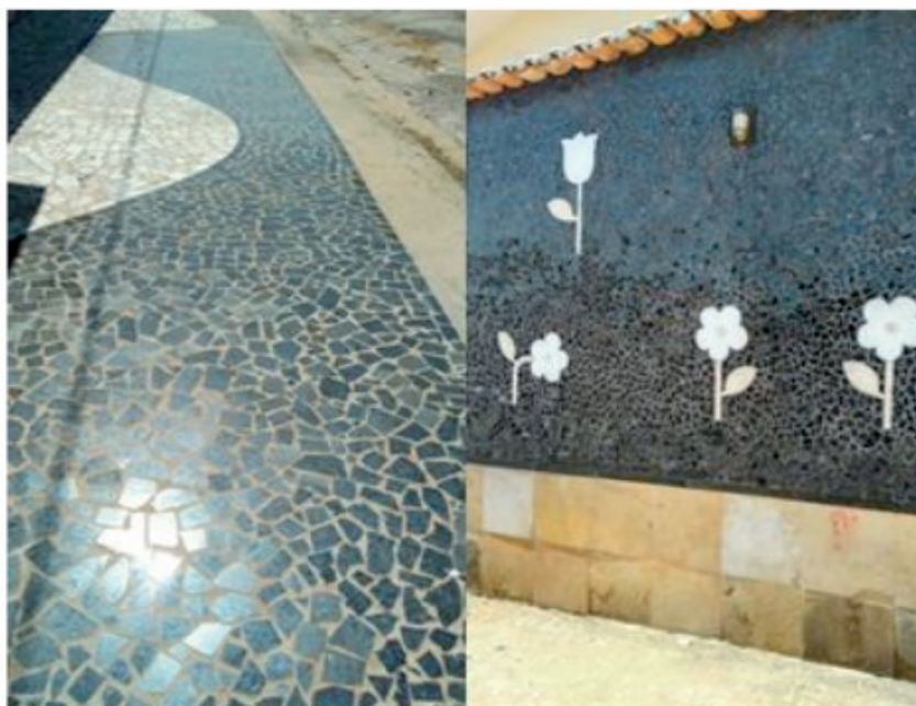
Figura 5. Calçada e muro revestido com sobras de material
