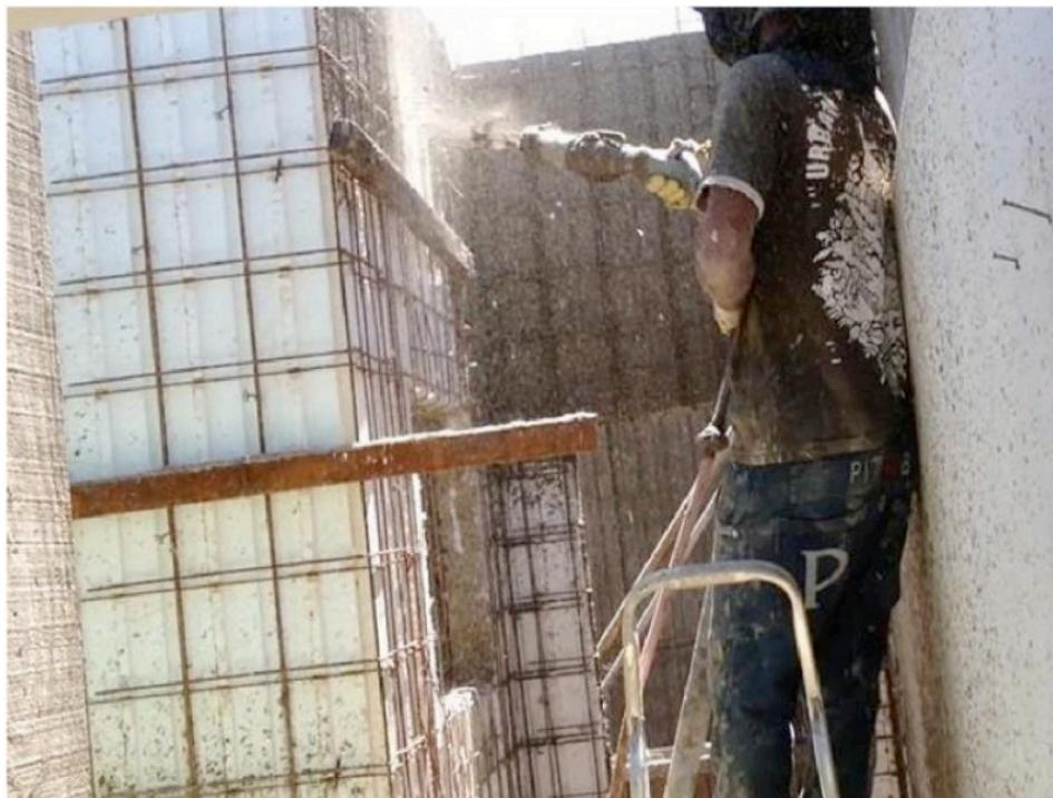
Figura 11 - Revestimento das Paredes
