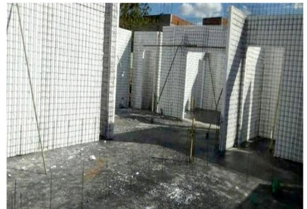
Figura 7 - Paredes Montadas
