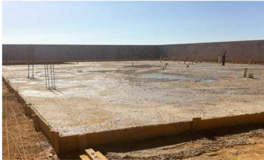
Figura 3 - Radier concretado
