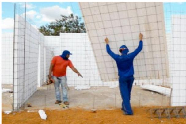
Figura 6 - Facilidade de transporte dos painéis
