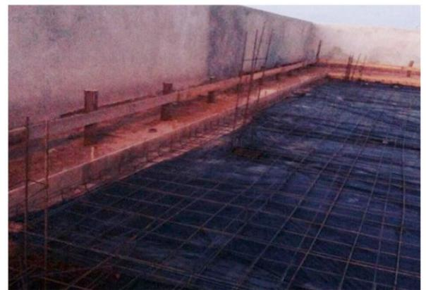
Figura 2 - Radier pronto para concretar
