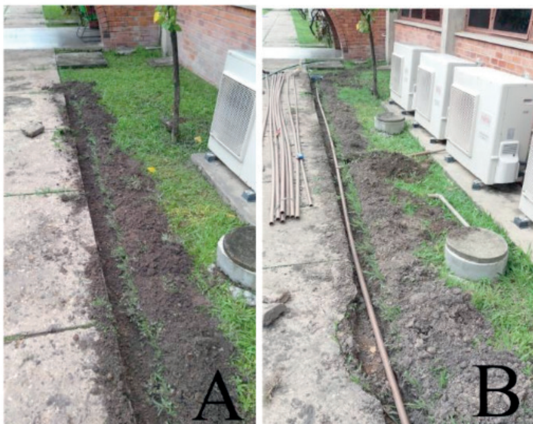
Figura 2: Escavações para passagem da tubulação (A) - Passagem dos canos (B). Fonte: Sistema de Captação de Água Proveniente dos Ares-Condicionados IFPI (2017).
