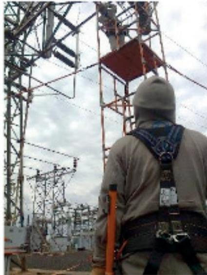
Na ocorrência de uma emergência, o resgatista escala o andaime portando os equipamentos de resgate: corda, mosquetão tripla trava, cinta de poliéster e polia;
