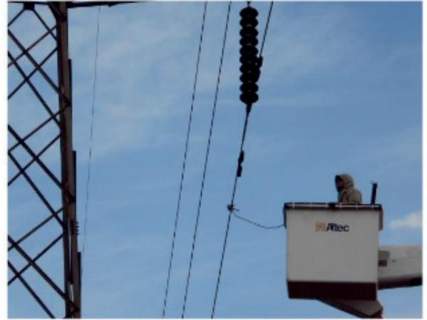
A solução encontrada foi desenvolvermos um acoplamento automático instalado no cabo de equalização do cesto aéreo, possibilitando o saque do equipamento da instalação.
