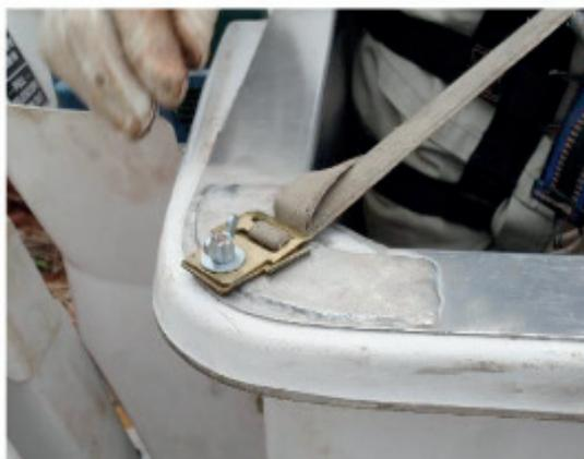
Para equalização a instalação energizada utilizamos cabos de cobre extra flexível de 35mm<sup>2</sup>, presos ao cesto metálico e com grampos para conexão as partes energizadas.
