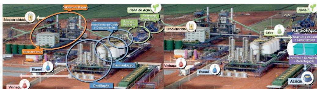
Figura 2: Principais processos da destilaria de etanol e da usina de açúcar.
