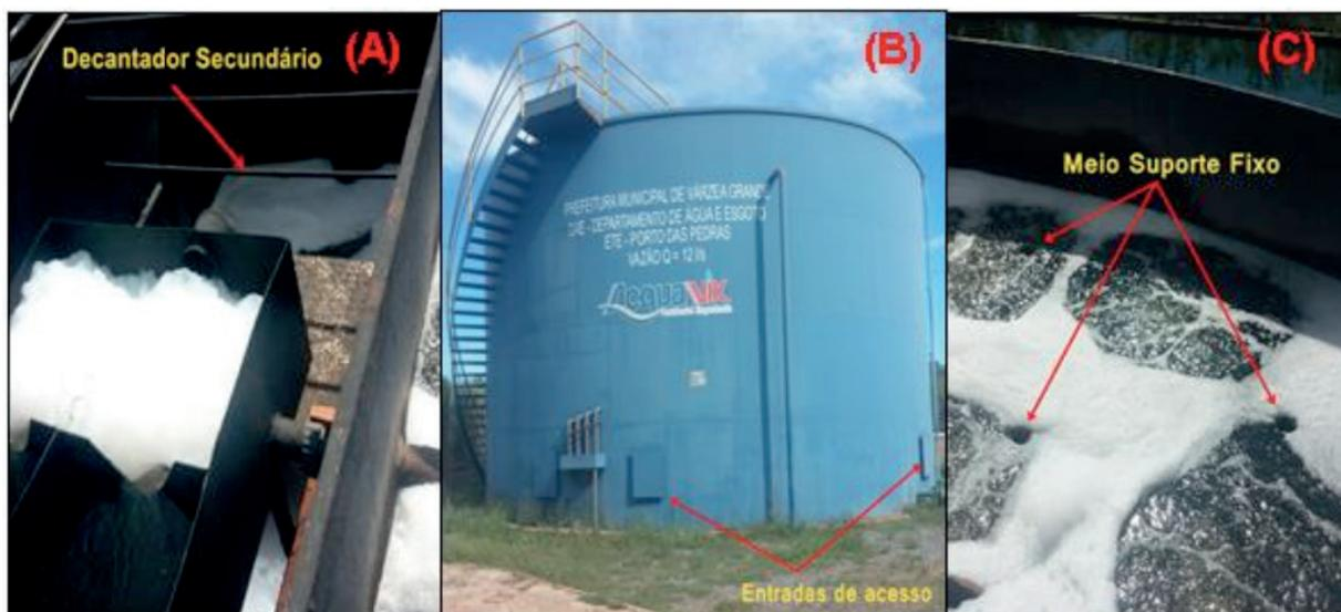
Figura 3 - Unidades do Tratamento Secundário. (A) Decantador Secundário. (B) Unidade Compacta com indicação das entradas de acesso da mesma. (C) Indicação do Meio Suporte Fixo no FBASN.
