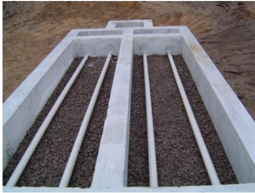
Figura 1: Biofiltos Submersos na época da construção
