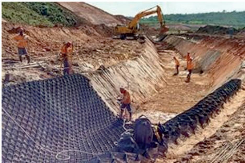
Figura 1 – Revestimento de canais utilizando geocélula. Fonte: TDM.
