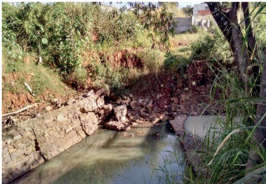
Figura 11 – Erosão na margem direita
