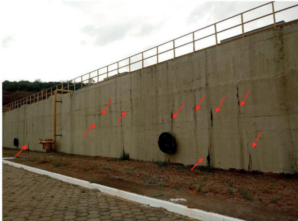
Figura 2 - Reator UASB da ETE pesquisada com fissuras (setas).
