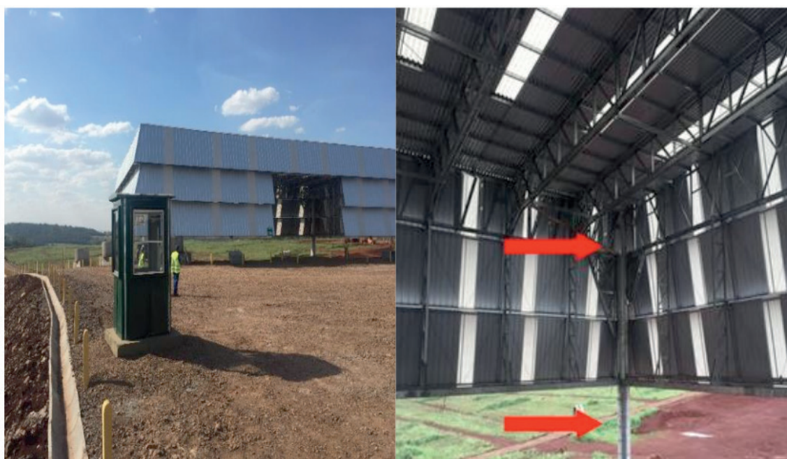
Figura 3 – Sistema de captação de água da chuva
