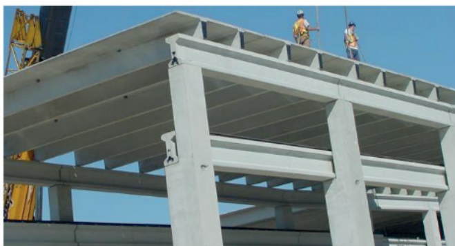
Figura 5: Aplicação de concreto
