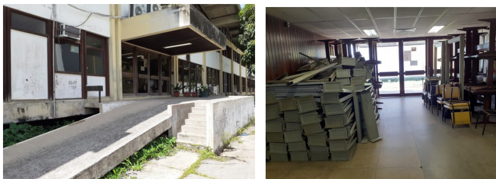
Figura 13: Vista da saída lateral externa e interna da biblioteca central
