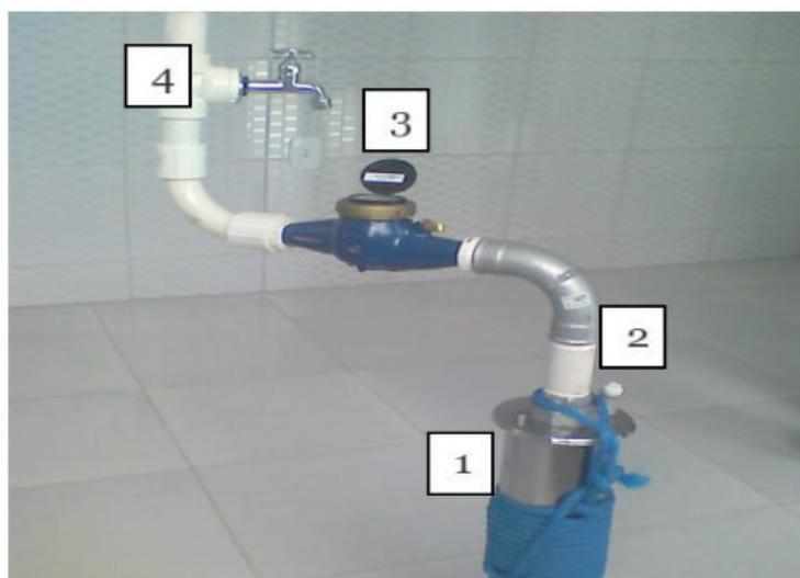
Figura 7: Modelo fotográfico de instalação dos dispositivos para outorga do poço artesiano.
