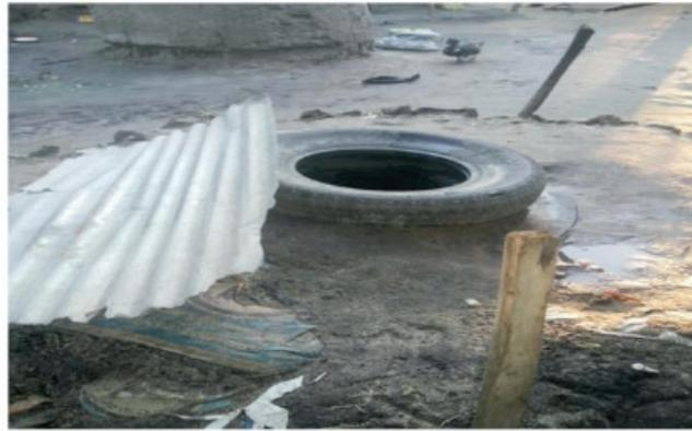
Figura2: Poço sem proteção adequada.
