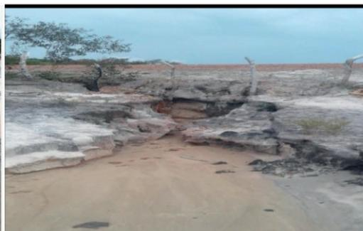
FIGURA 15 – Erosão no aterro da rodovia
