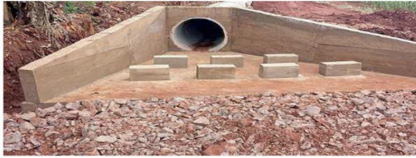
FIGURA 8 – Boca de bueiro com dissipador localizado
