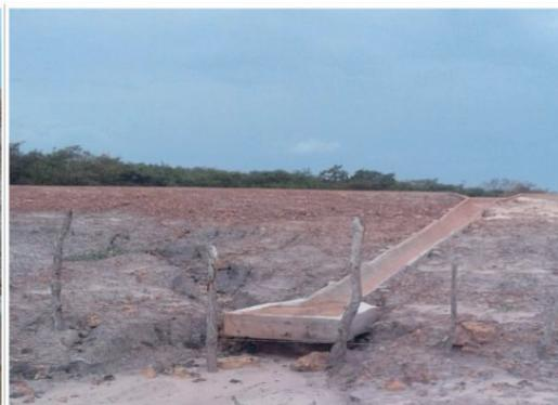
FIGURA 13 – Descida d'água e dissipador de energia
