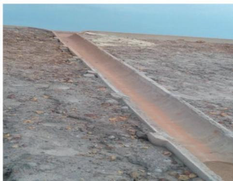
FIGURA 12 – Descida d'água
