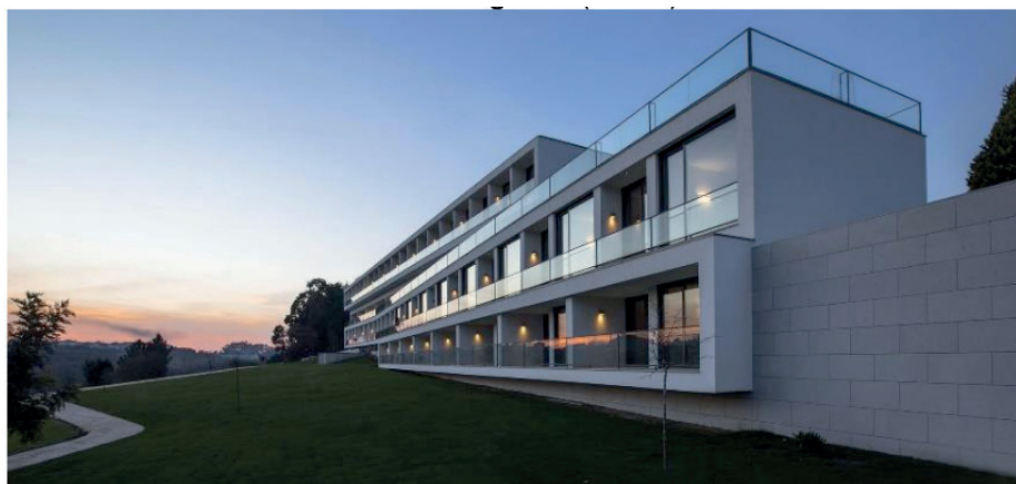
Figura 2: Torre Sênior, Portugal
